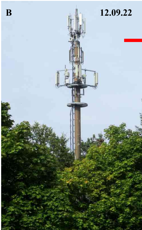
Sendeanlage Nr. 310043 Höhe: 26,4- 32,6 m, 45 Antennen
