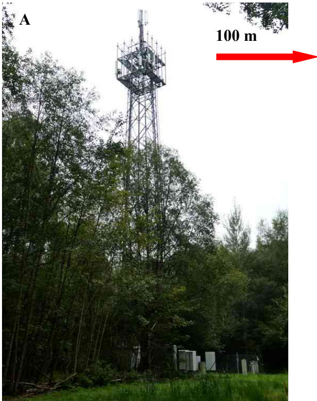
Sendeanlage Nr. 311992 (Blick von N) Höhe: 35,5 - 44,4 m
